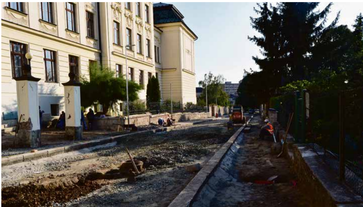
Oprava ulice Kamenná stezka (2016)
